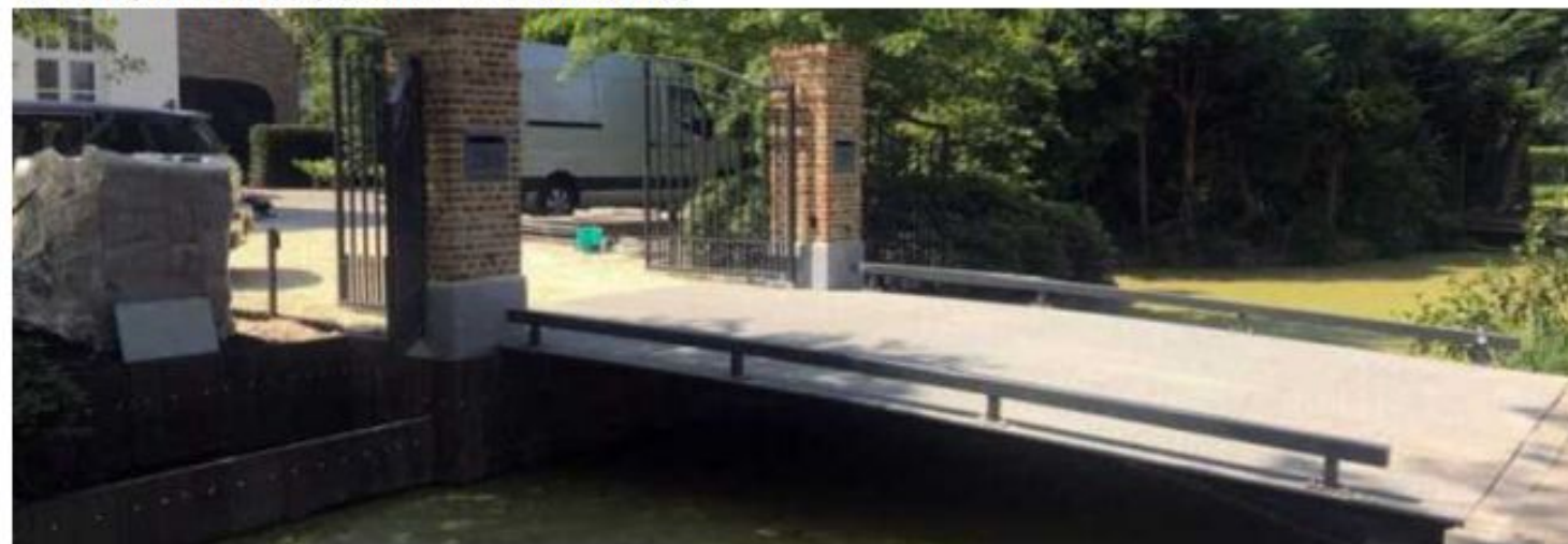
2: BETONNEN BRUG MET LAGE RAILING
